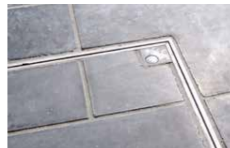
Évacuation: couvercle de pavage en alu 40x40 BigMat (suppression du goutte à goutte)
