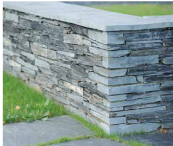
Muret bas: hauteur 50cm en moellons de schiste avec couvre mur (L100x130) idem matière
