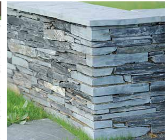
Muret bas moellons de schiste
